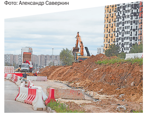
Работы по строительству нового проезда в самом разгаре.
