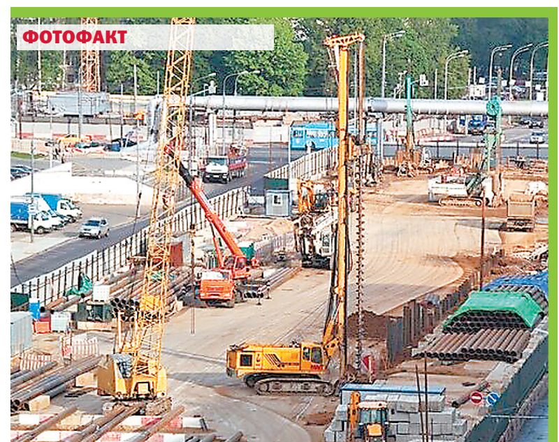
Смотрим, как строится станция метро «Зюзино». Фотоотчёт Елены Мамакиной размещён на интернет-странице «Зюзино» (yandex.ru/local/users/5762425).
