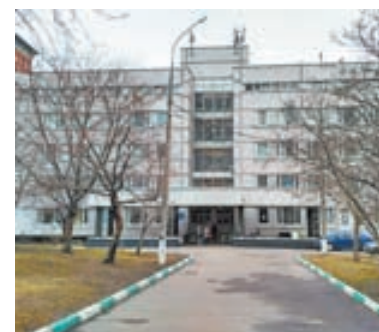
В поликлинике № 130 капремонт ожидается в 2020 г.
