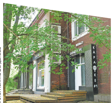
Двухэтажный универмаг на улице Богданова, 56А.
